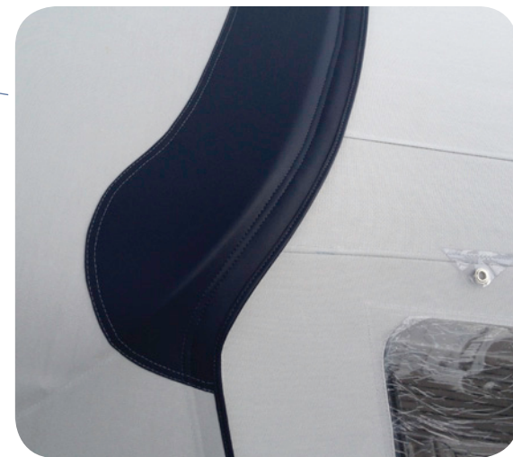
Reißverschlüsse in Anschlußelementen erhalten grundsätzlich eine Abdeckung.
